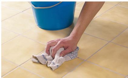
4. Подготовка поверхности, удаление пыли. Поверхность цементно-песчаной стяжки под наклейку мата необходимо загрунтовать. Сетка мата имеет клеющую основу, однако для максимального эффекта пол должен быть очищен от грязи и пыли.
